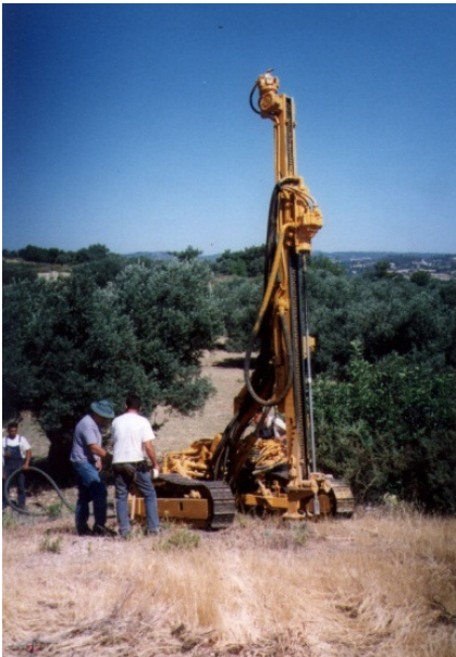
Reconnaitssances sismiques et sondages
